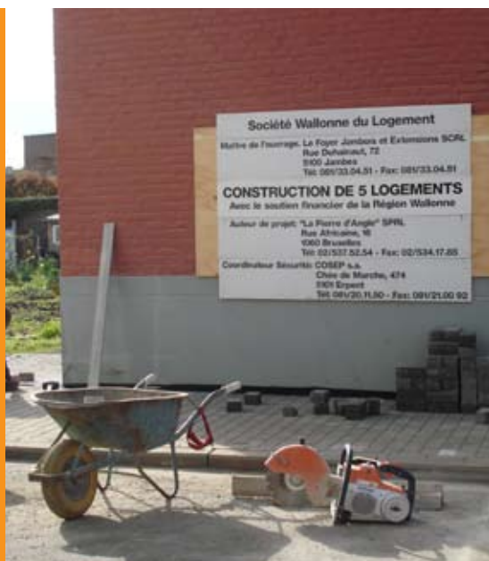
La Région wallonne encourage les sociétés de logements publics à réaliser davantage d'habitations adaptables.
