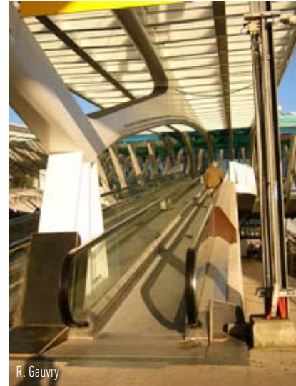
Le pourcentage de la pente de ces travellators est trop élevée (gare des Guillemins – Liège)
