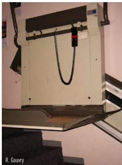
Élévateur d'escalier installé dans un cinéma de Liège
