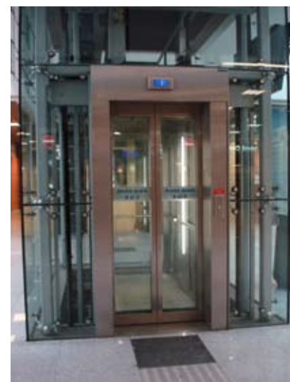
Dans la gare de Namur, les ascenseurs sont sécurisés : synthèse vocale, dalles podotactiles, etc.
